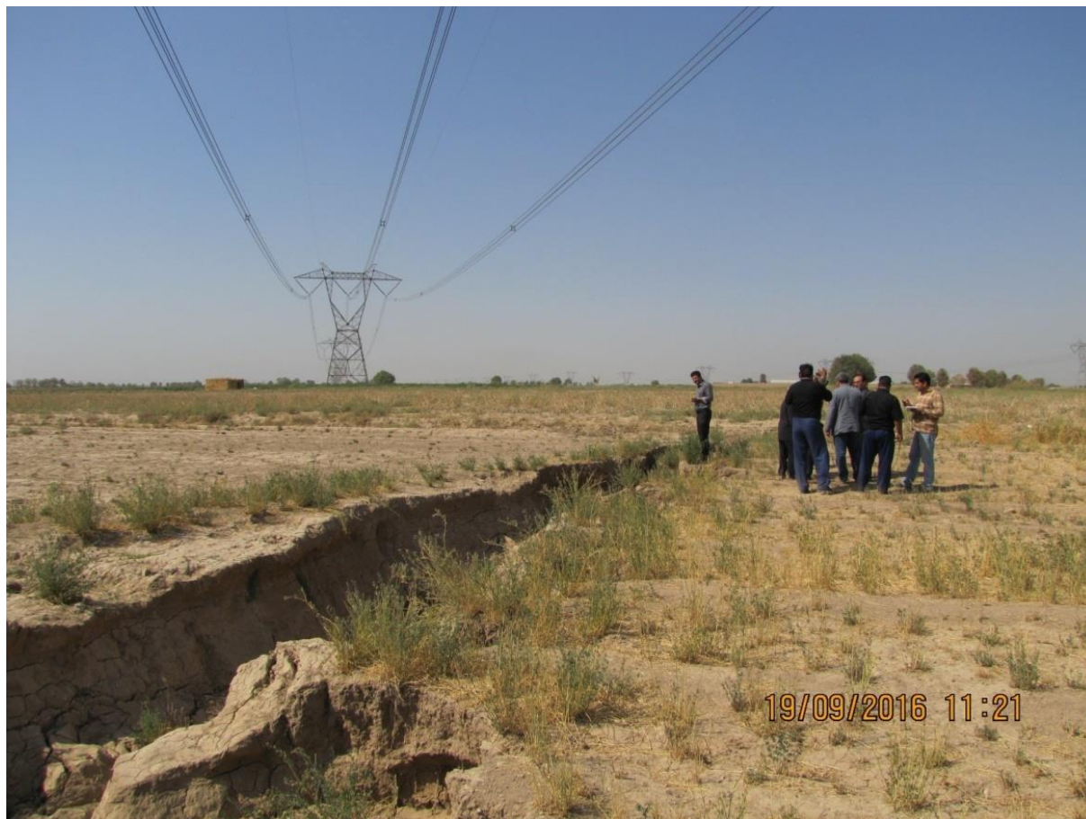
شکل ۱۰- ایجاد شکاف های عمیق در سطح زمین خطرات بر دکل های انتقال نیرو
