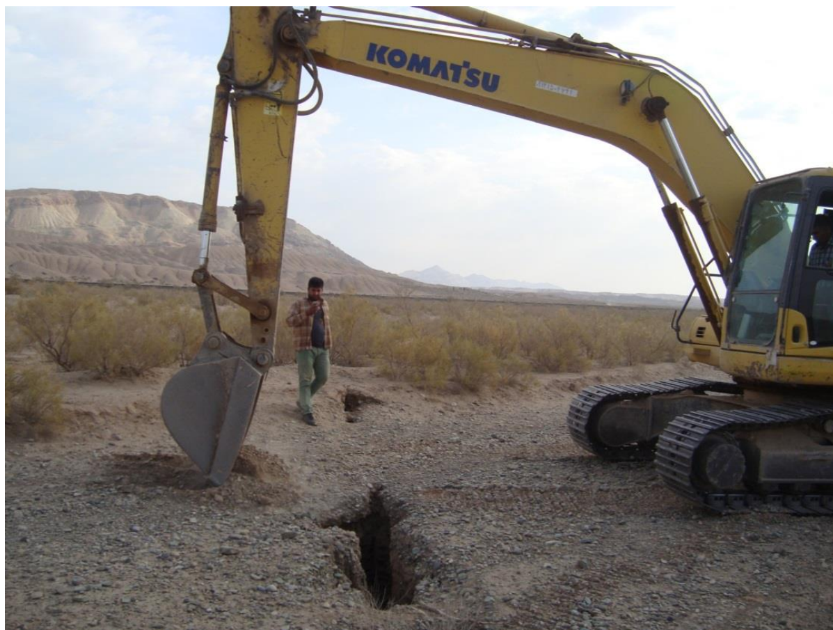
شکل ۱۲- حفر ترانشه با بیل مکانیکی در راستای عمود بر شکاف و ترک ناشی از فرونشست زمین در دشت ورامین
