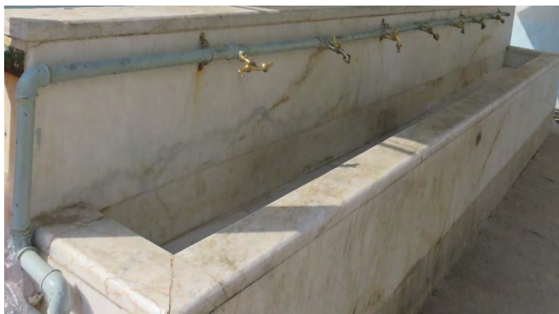
شکل ۶ - شیر پیچی نصب شده بر روی سکوی یک مرکز آموزشی
